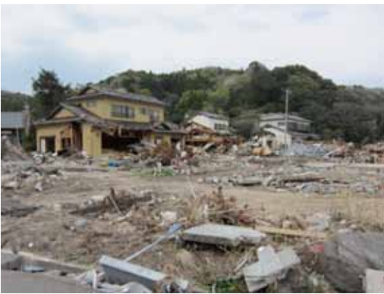
津波で被害を受けた地域の様子(5月上旬)
